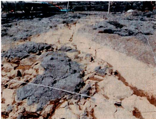
本体基礎掘削状況の確認
