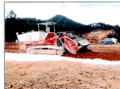
軟弱土に生石灰を混合し土質を改良 (スタビライザを用いた固化剤(生石灰)の混合状況)
