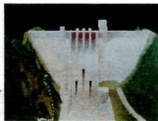
ゲート設備及びダム管理棟に電力を供給し機能を確保
