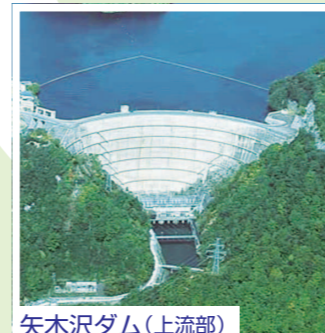
矢木沢ダム(上流部)
