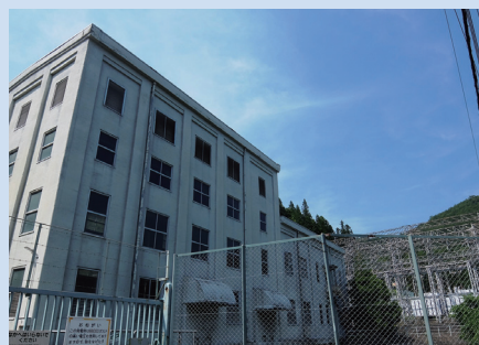
東京電力・松谷発電所
