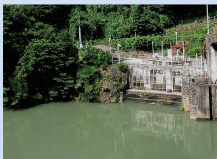
ハッ場ダム予定地上流にある長野原取水堰。吾妻川の水の大半は現在ここで取水され、ダム予定地下流の東京電力・松谷発電所に運ばれている。
