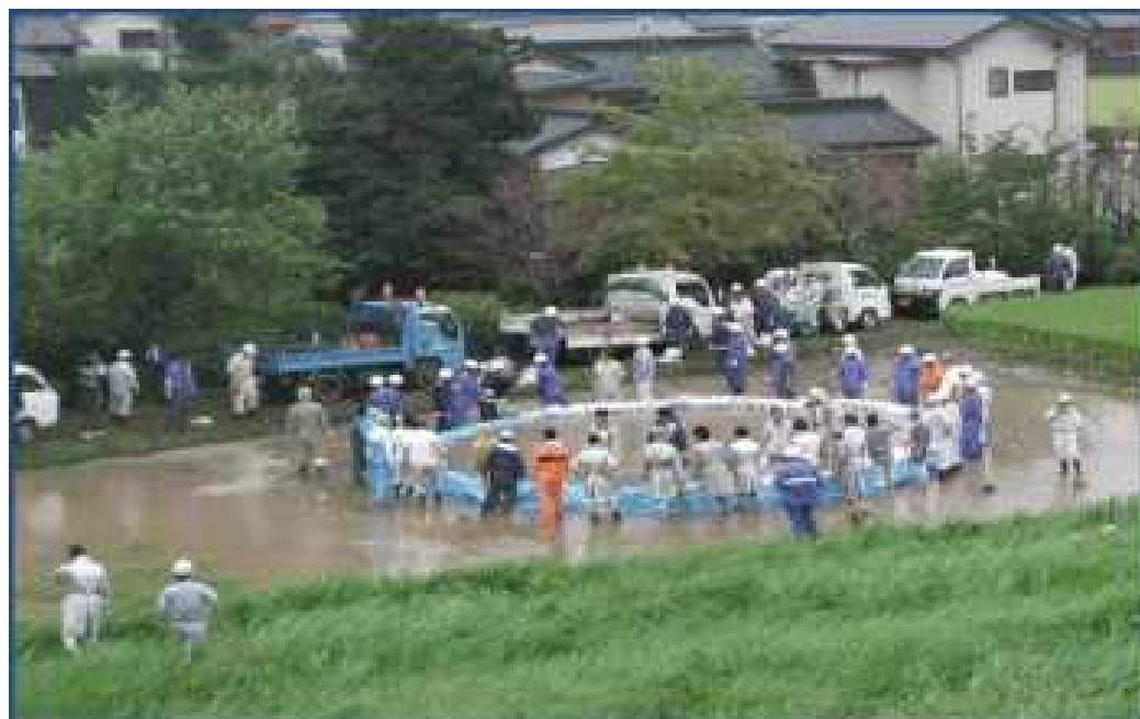
●埼玉県加須市漏水状況(H13台風15号)
