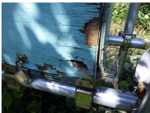
地盤伸縮計 HS-006 の収納箱の破損
