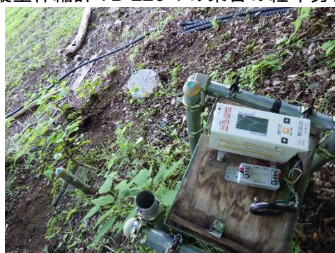
縦型伸縮計 YB-256-1 の架台の経年劣化
