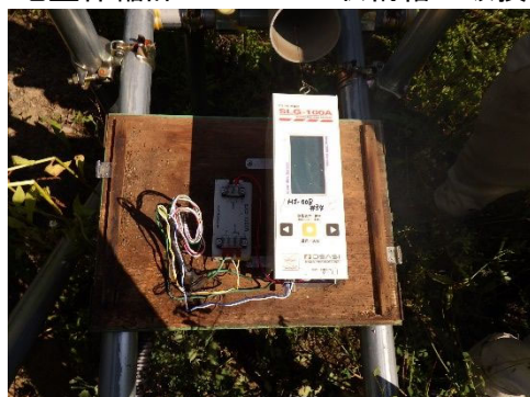
地盤伸縮計 HS-008 の収納箱の経年劣化
