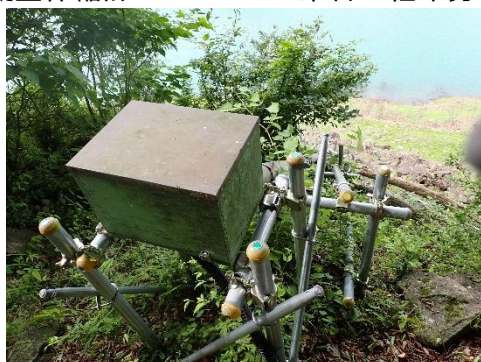
縦型伸縮計 KYB-260-1 の架台の経年劣化
