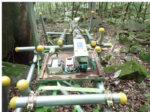
地盤伸縮計 YS-003 の架台の経年劣化
