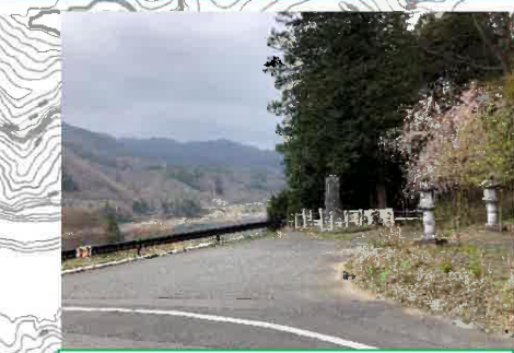
駐車場所 6 川原湯温泉トンネル付近
