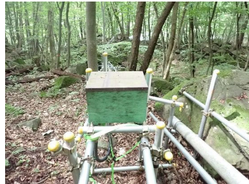
地盤伸縮計 YS-002 の架台の経年劣化
