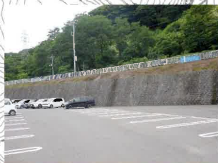
駐車場所 3 長野原めがね橋下付近 地すべり全景を確認する必要があるときのみ使用。
