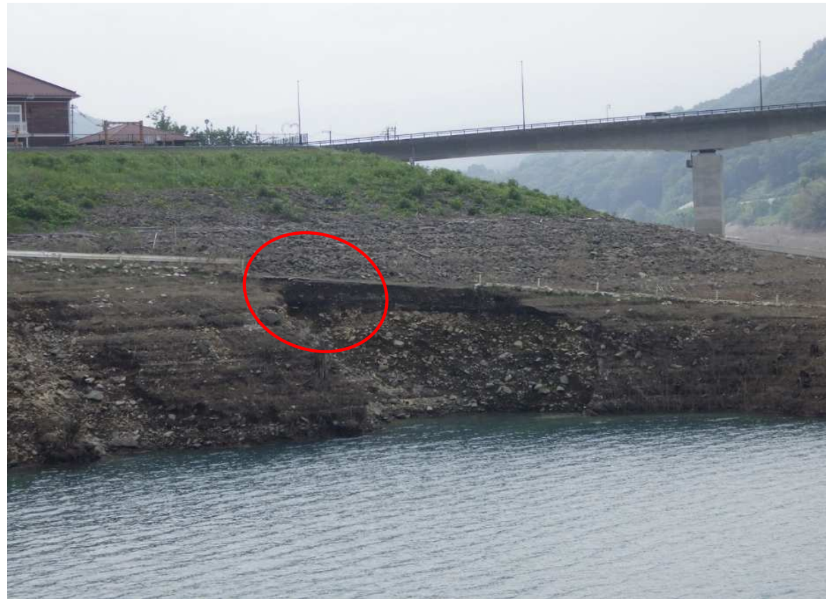
①全景状況(正面) 撮影日:令和7年6月13日 現地状況 : 浸食の拡大が認められる。
