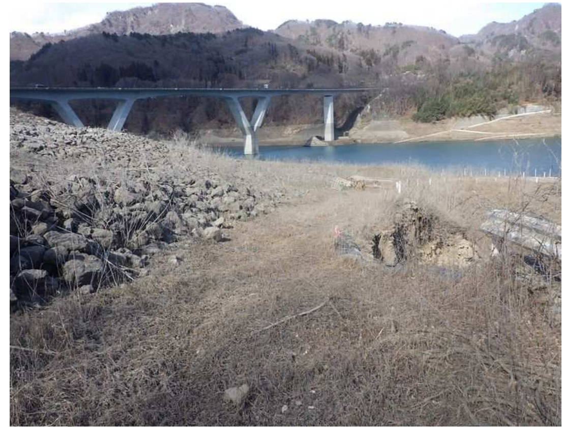
②浸食箇所背面の路面 撮影日: 令和7年2月7日 現地状況 : 浸食の拡大は認められない。
