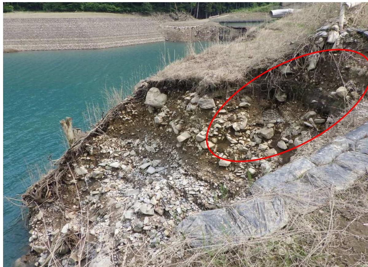
③全景状況(沢下流側) 撮影日:令和7年6月13日 現地状況 : 浸食の拡大が認められる。
