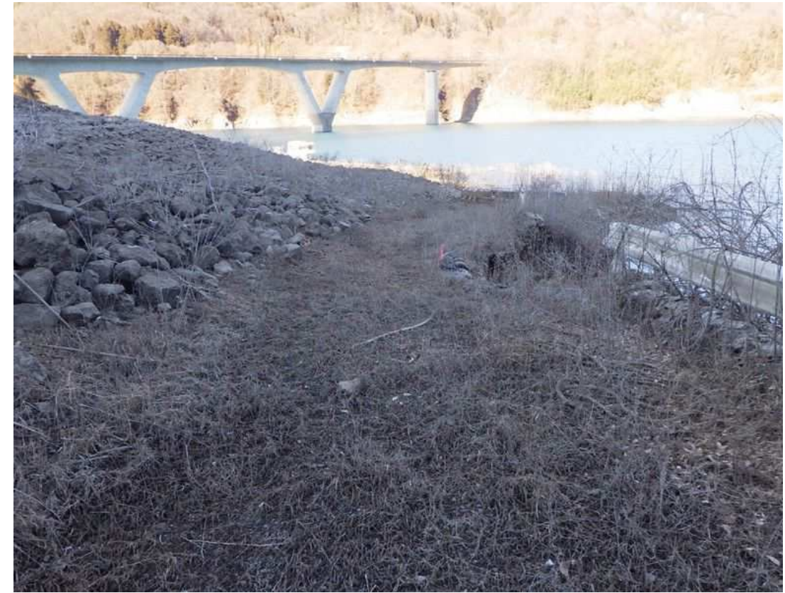
②浸食箇所背面の路面 撮影日:令和7年1月16日 現地状況 : 浸食の拡大は認められない。
