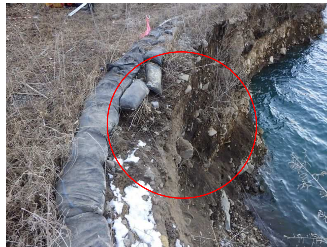
④浸食箇所頭部の状況 撮影日:令和7年1月16日 現地状況 : 2024.9月と比較し、一部浸食の拡大が認められる。
