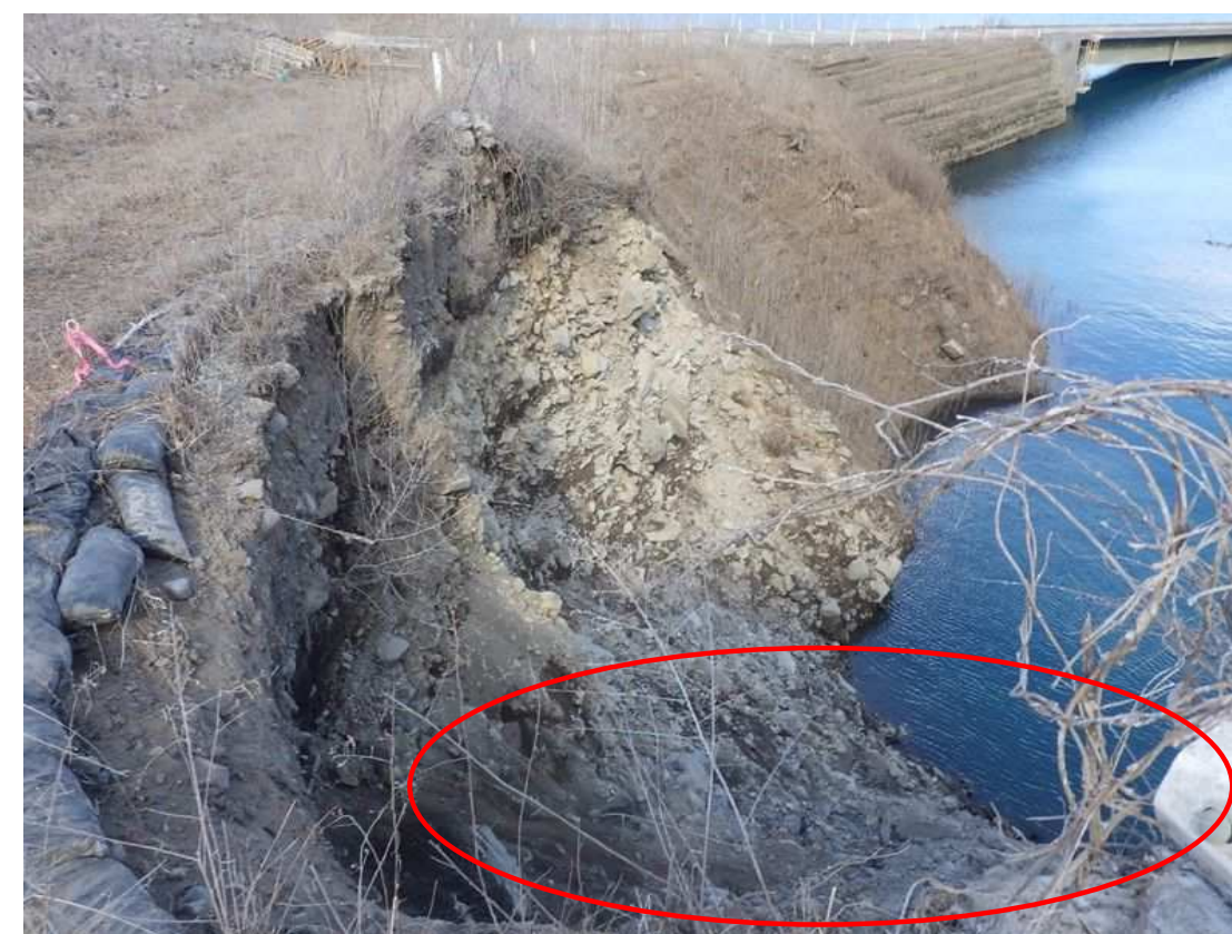
④浸食箇所頭部の状況 撮影日: 令和7年2月7日 現地状況 : 2024.9月と比較し、一部浸食の拡大が認められる。
