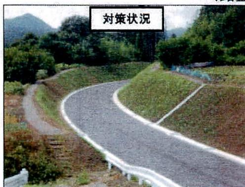
大柏木地区工事用道路において、降雨による路盤の浸食対策及び隣接する集落に対する粉塵防止対策が必要となり、瀝青安定処理を実施
