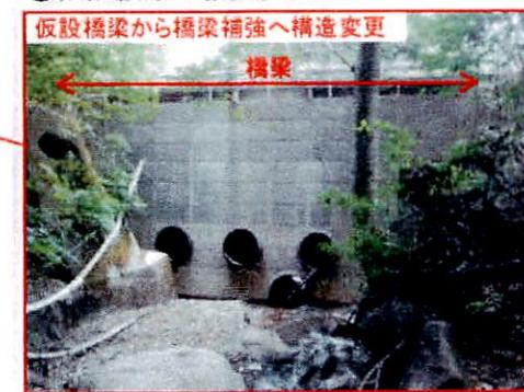
※ 既存の橋梁をコンクリートで固め補強 38
