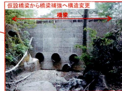
※ 既存の橋梁をコンクリートで固め補強
