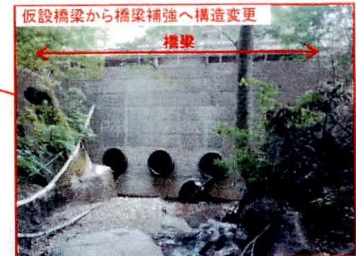
※ 既存の橋梁をコンクリートで固め補強 38
