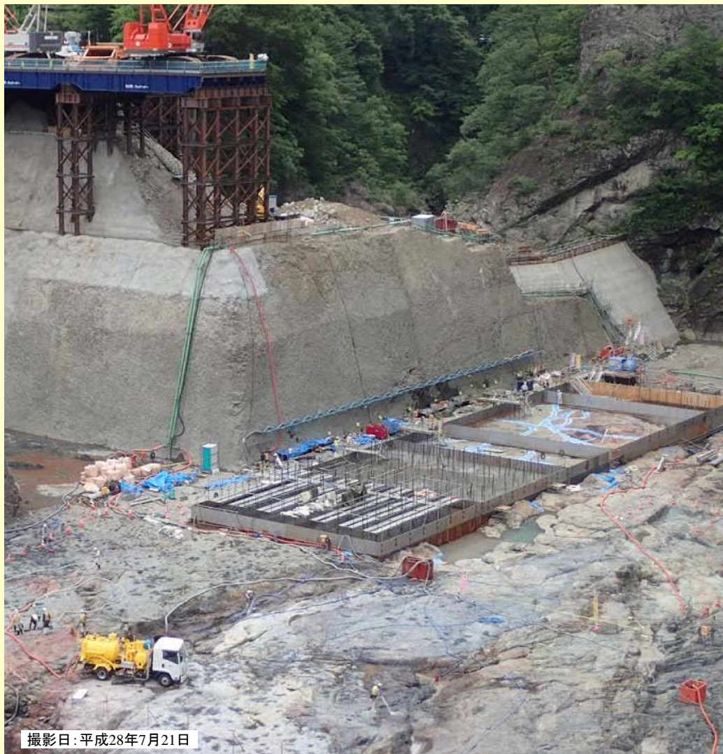
本体工事(減勢工)
