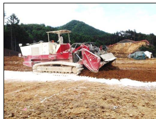
軟弱土に生石灰を混合し土質を改良 (スタビライザを用いた固化剤(生石灰)の混合状況)
