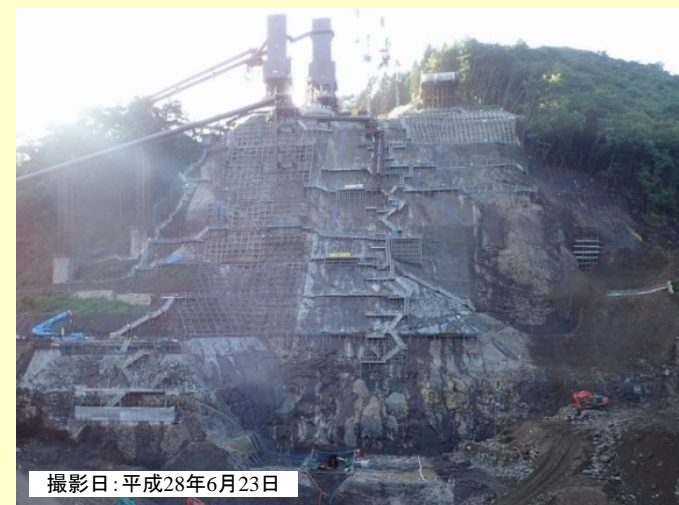
本体工事(基礎掘削(左岸))
