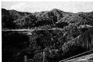
ハッ場ダム 本体関連工事現場
