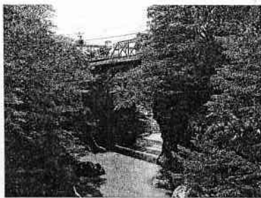
溪谷にかかる吾妻線 しかし、向こうにはつけかえ国道の建設が進む
