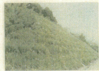
【簡易吹付法枠(植生後)】
