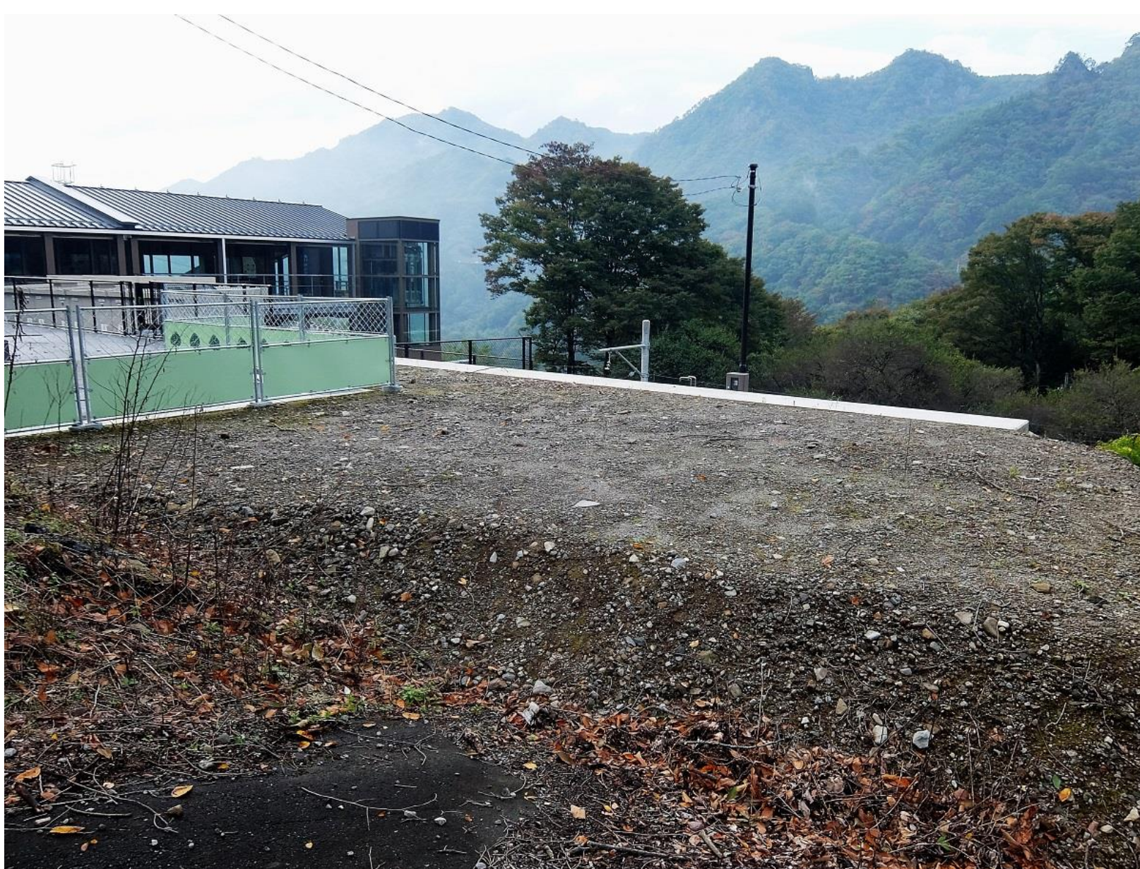
川原湯温泉駅の脇にある草が生えていない土地(2015年10月11日撮影) 鉄鋼スラグによるものでは？
