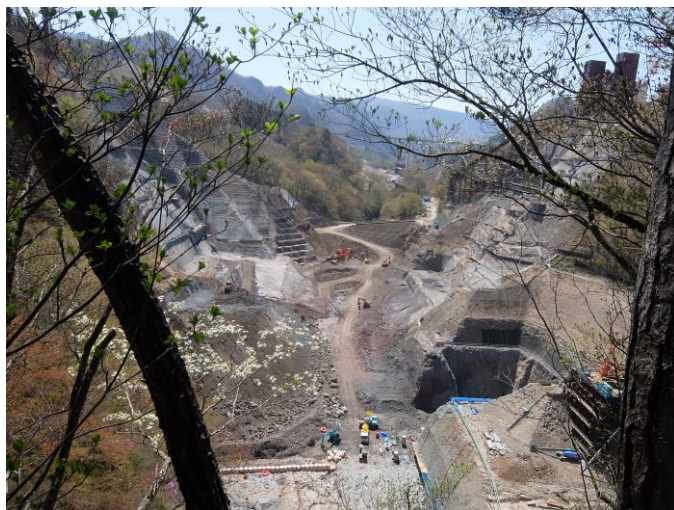
ハッ場ダム本体工事で惨状をさらす吾妻渓谷 (写真提供: ハッ場あしたの会)
