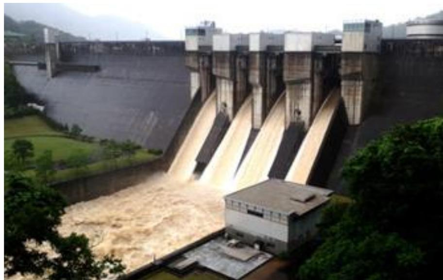
総貯水容量6600万m<sup>3</sup> / 有効貯水容量 5800万m<sup>3</sup> / 洪水調節容量 4200万m<sup>3</sup>
