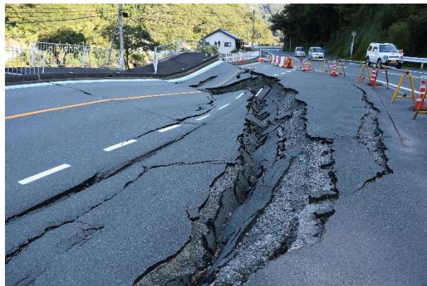
肱川の洪水で基礎が破壊された国道197号（2018年8月3日撮影）
