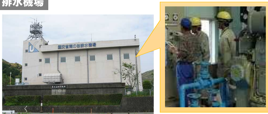
現地での監視・操作
