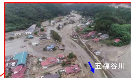
土砂・洪水氾濫状況
