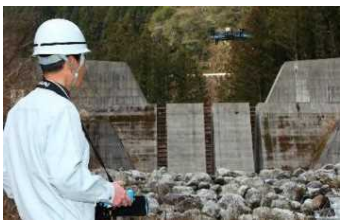
ドローンを活用して砂防施設の点検を実施
