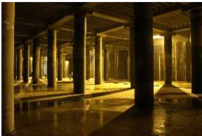
大規模地下貯留施設
