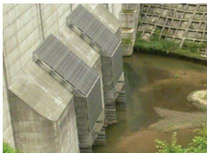
現在、全国で5つの流水型ダムが運用されている。川辺川ダムは、既存最大の益田川ダムと比べると、総貯水量で約20倍、集水面積で約5倍、湛水面積(水没面積)で約7倍の、けた違いの巨大ダムである。流水型ダム(穴あきダム)の最大の弱点は、穴がダムの下部にあるために、洪水時に流れる大量の流木や土砂、岩石などがダムの穴に押し寄せ、穴がふさがる点である。
