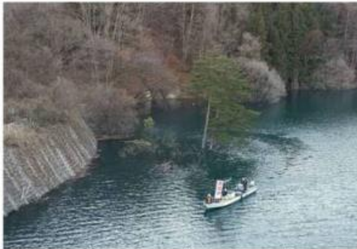
写真 3-4-1-6 岸沿いの測深状況
