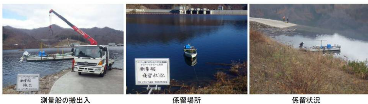
図 3-4-1-2 測量船の搬入と係留状況
