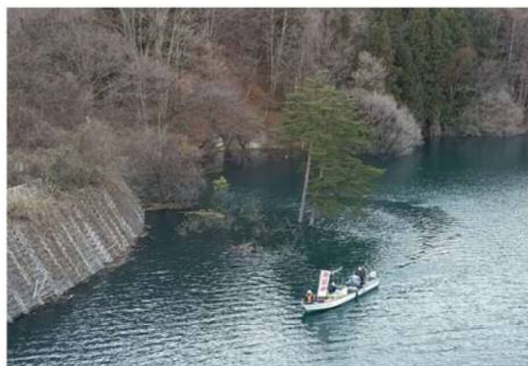
写真 3-4-1-6 岸沿いの測深状況
