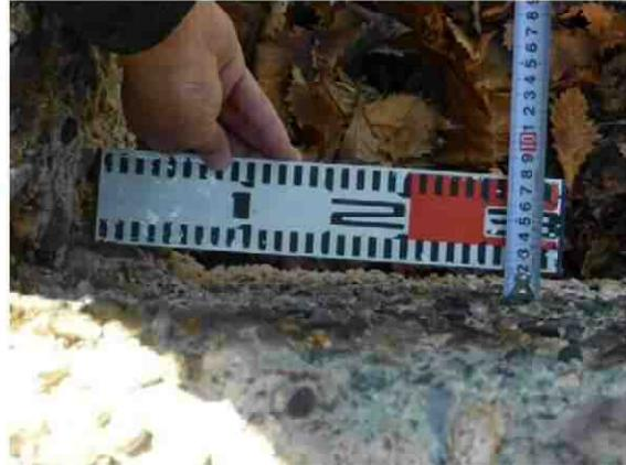
写真 2-3-28 源泉保護擁壁 下部腐食計測
