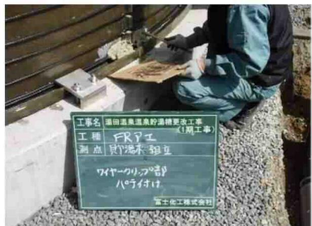
写真 2-5-6 FRP 筒固定用金具設置状況
