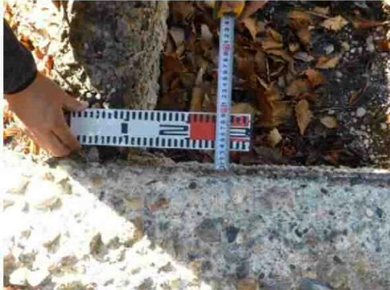
写真 2-3-27 源泉保護擁壁 中間部腐食計測
