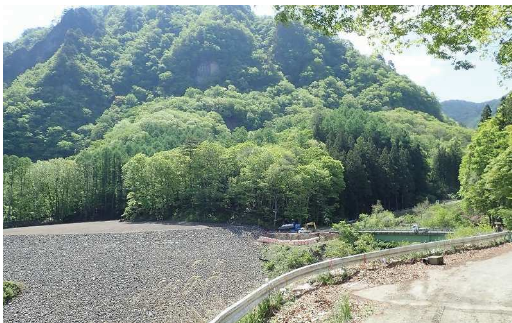
図 9.2 横壁地区（白岩沢）全景
