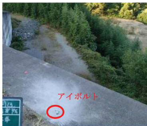
<横壁地区の擁壁天端のアイボルト設置状況>
