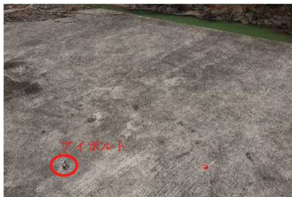
<長野原地区の擁壁天端のアイボルト設置状況>
