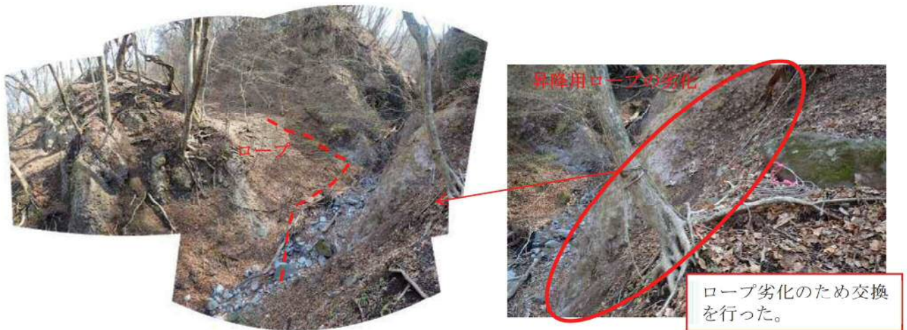
<①転倒防止用のロープ、昇降用のロープを設置>
