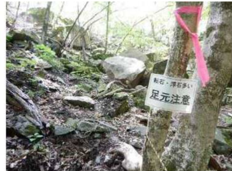
<②注意看板の設置>
