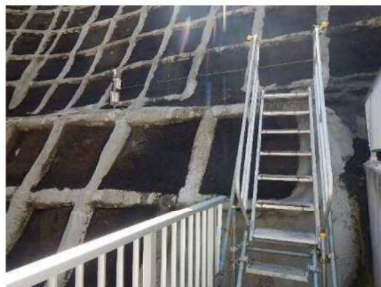
<②ダムサイト右岸の安全施設設置状況>
