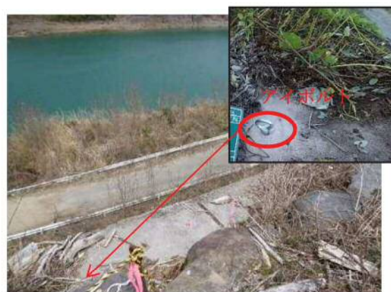
<横壁地区の擁壁天端のアイボルト設置状況>
