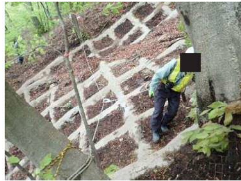
<②斜面を横断する箇所のロープ再設置>
