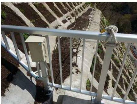
<①ダムサイト左岸の安全施設設置状況>
