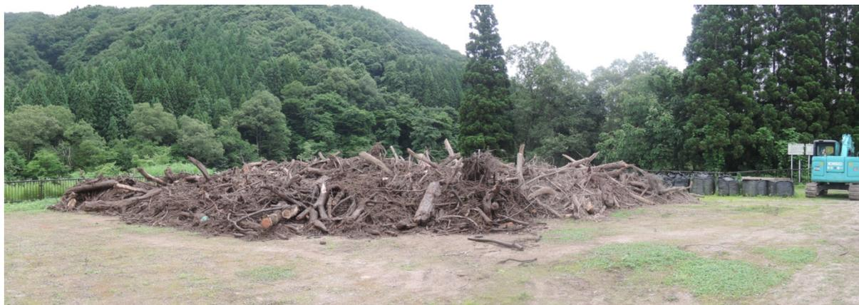
洪水などで、常用洪水吐に堆積し掘削・撤去された流木と土砂
