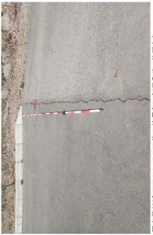
写真⑦付近のアスファルトの施工境界部に割目発生。前回からわずかに割目の拡大が認められる。
