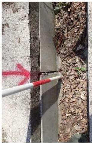
写真⑤付近のアスファルトの施工境界部に割目発生。前回からわずかに割目の拡大が認められる。
