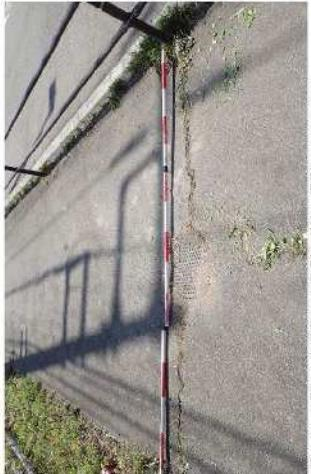
④ L32-3頭部の歩道路面の亀裂の状況 撮影日: 2023/4/4
