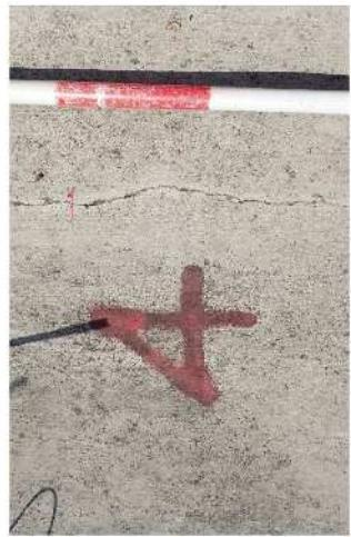
写真⑥付近のアスファルトの施工境界部に割目発生。前回からわずかに割目の拡大が認められる。
