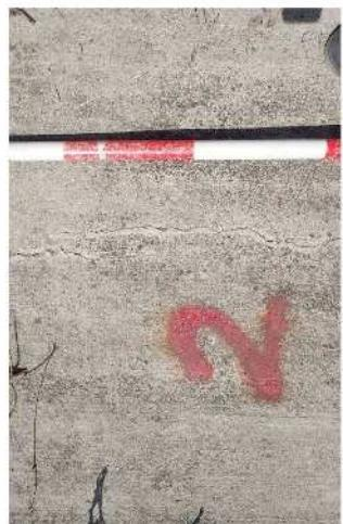
写真③範囲の水路工小段面のヘーアークラック、0.7mmの開口割目、前回から拡大はない。
