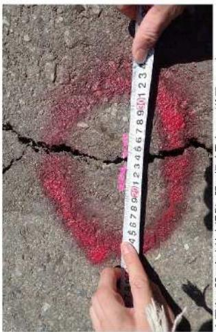
写真④範囲の水路工小段面のヘーアークラック、0.8mmの開口割目、前回から拡大はない。
