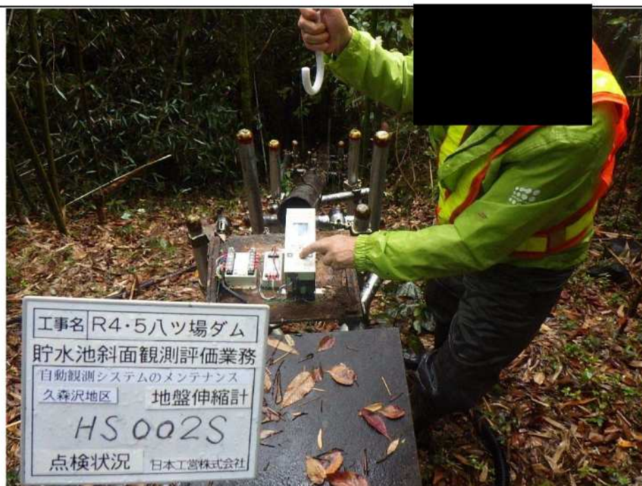
写真 13.5 久森沢地区地盤伸縮計（HS-002S） 点検実施状況
