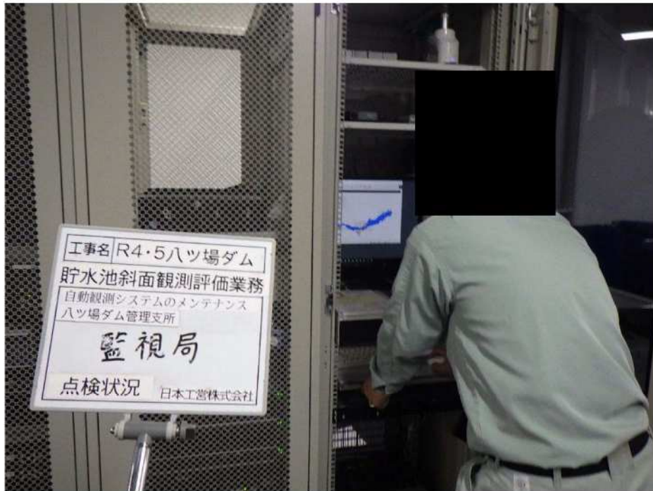
写真 13.1 監視局 点検実施状況
