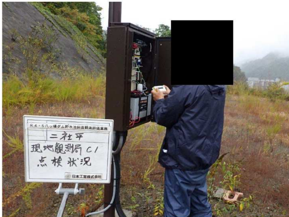
写真 13.2 ニ社平地区現地観測局（C1） 点検実施状況
