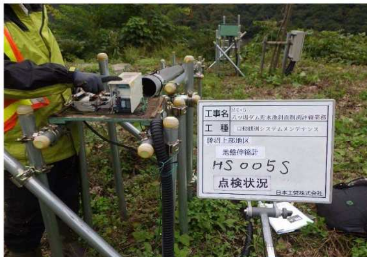
写真 13.9 HS005S 現地状況
