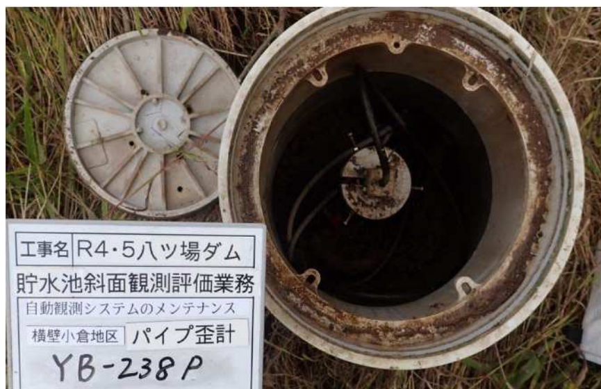
写真 13.21 YB238P 現地状況
