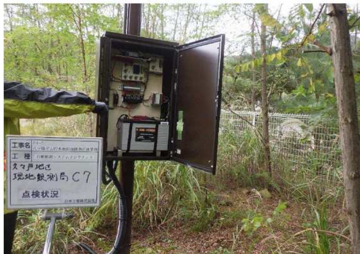
写真 13.23 C7 現地状況
