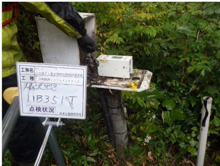
写真 13.7 HB351V 現地点検状況
