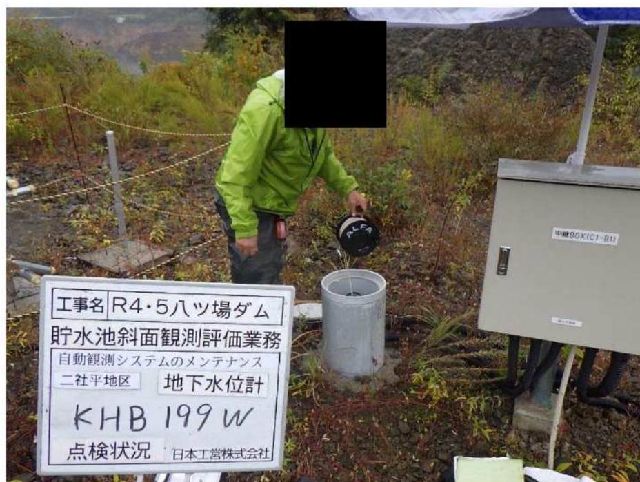
写真 13.4 二社平地区地下水位計（KHB-199W） 点検実施状況
