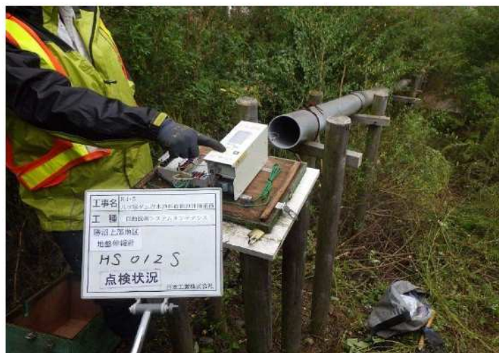
写真 13.11 HS012S 現地状況
