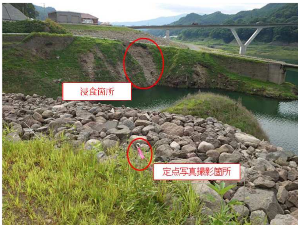
写真 14.1 定点写真撮影箇所の状況および浸食斜面の眺望
