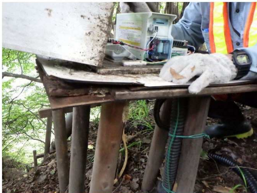
写真 13.8 HS011S 現地状況
