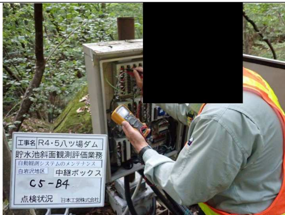
写真 13.3 白岩沢地区中継ボックス（C5-B4） 点検実施状況
