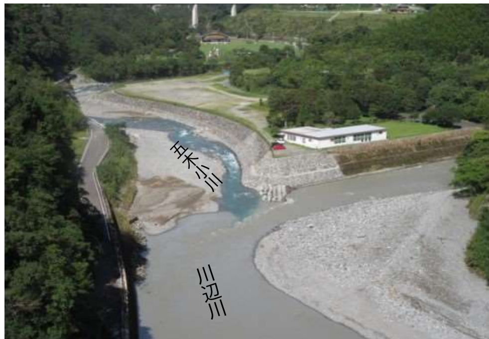
縦木砂防ダムから流れ込んでくる濁水
