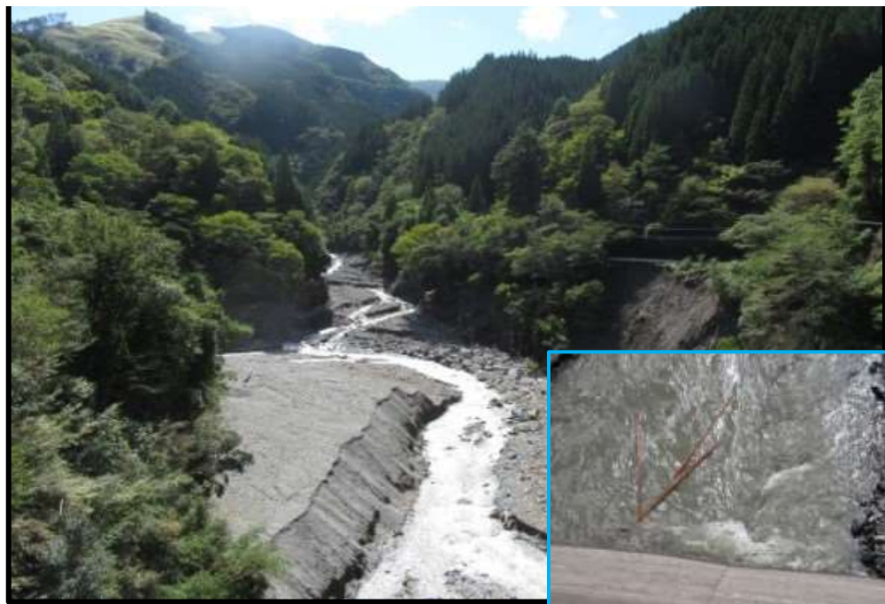
縦木砂防ダム上流
