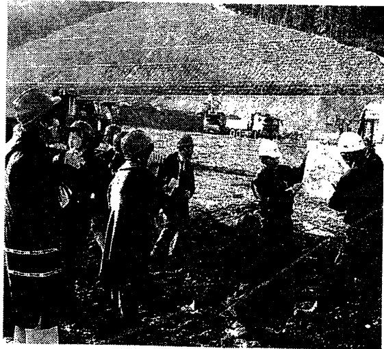
国交省の担当者の説明を聞く参加者の 長野原町の「代替地」工事現場で
