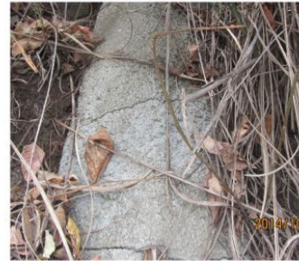
法枠に亀裂発生
