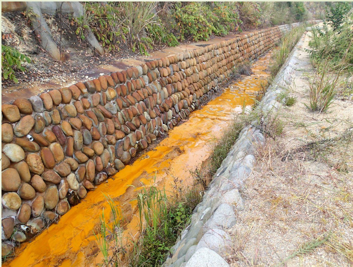
川原畑代替地の国道側道脇の側溝の様子（2014年10月） 変質帯から染み出る水が酸性（pH1程度）のために鉄を溶かしこみ、 地表で酸化されて赤色の水酸化鉄等が沈殿
