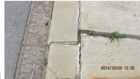
法枠に亀裂発生
